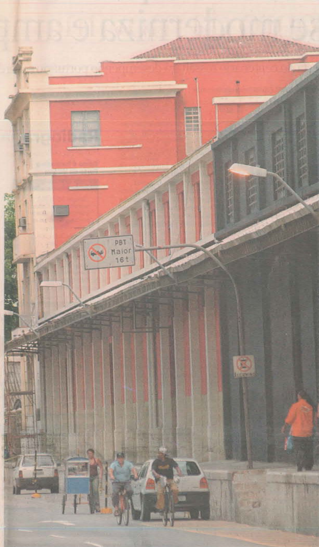
NOVO VISUAL. A pintura das paredes frontais dos armazéns já foi iniciada
