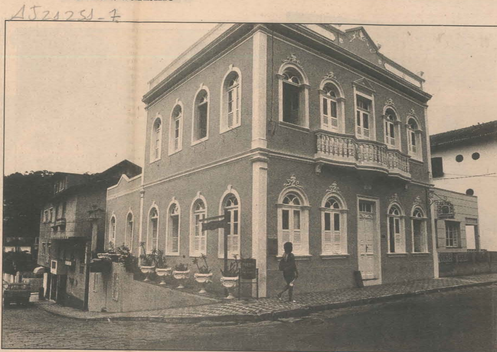
Casa da Cultura, o marco arquitetônico em Domingos Martins
