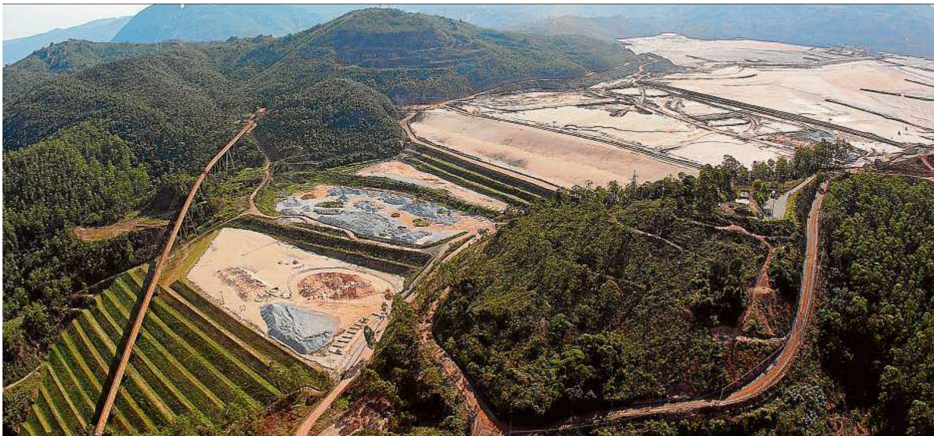
A barragem de Germano tem trincas nas estruturas, decorrentes do rompimento de Fundão, que estão sendo monitoradas desde a tragédia do início do mês
