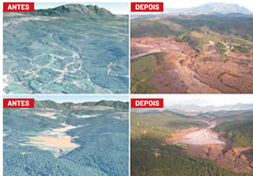
IMAGENS de antes do rompimento das barragens e após a enchente
