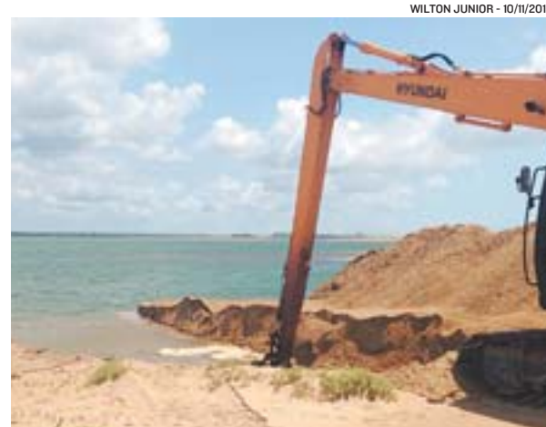
REGÊNCIA, onde canal foi aberto na areia para facilitar a passagem da lama do Rio Doce para o mar
