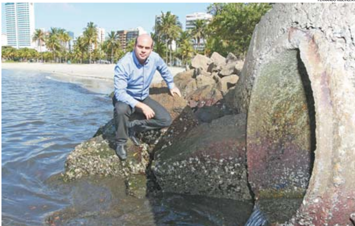
SERGIO PETERLE mostra esgoto lançado na Baía de Vitória. Donos de 13.200 imóveis terão de regularizar situação
