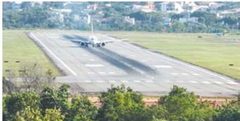
AVIÃO no aeroporto de Vitória: construção de novo pátio e nova pista
