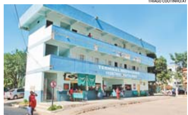
ATUAL terminal rodoviário de Presidente Kennedy: projeto trazia 12 baias de ônibus, centro de artes e dois andares
