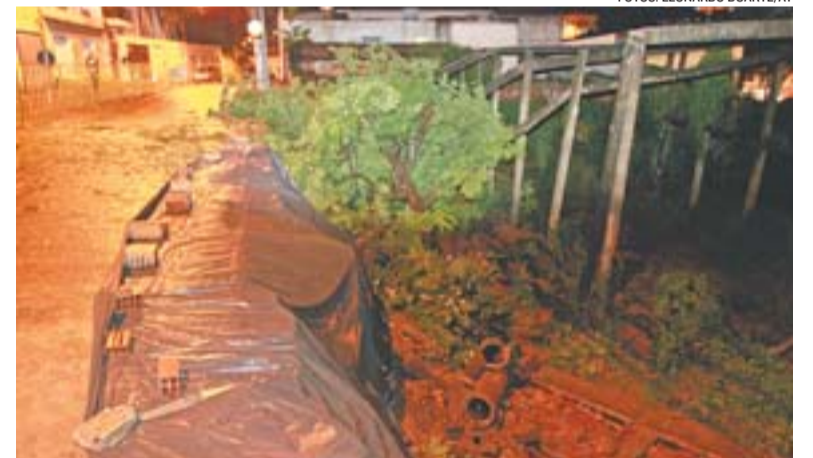
MURO CAIU devido a uma escavação irregular, segundo a Defesa Civil
