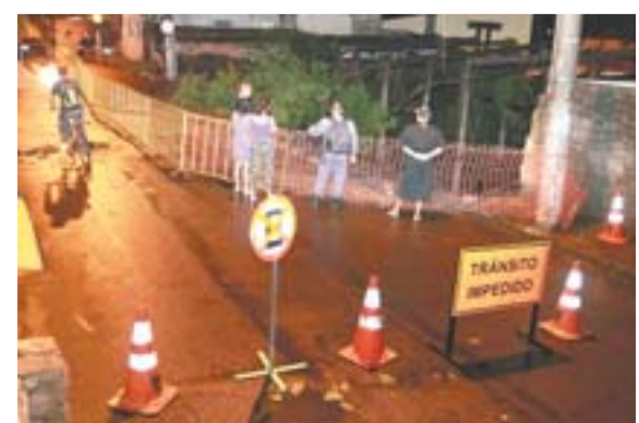
TRÂNSITO foi impedido em trecho da avenida Maruípe onde muro desabou e destruiu parte do asfalto
