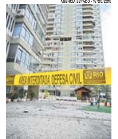
PRÉDIO onde houve explosão
