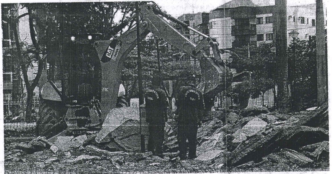
CANTEIRO DE OBRAS. Parte do piso foi retirada por funcionários e máquinas da prefeitura
