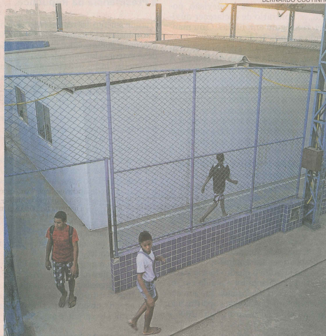
REFORMA. A quadra serve de abrigo para os módulos que servem de sala de aula, durante obras
