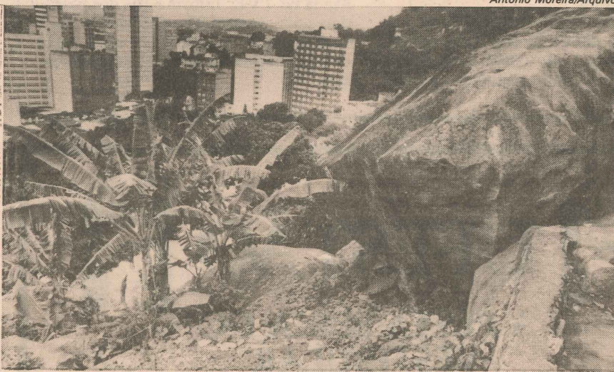
No Morro do Moscoso 50 casas estão ameaçadas pelas pedras soltas
