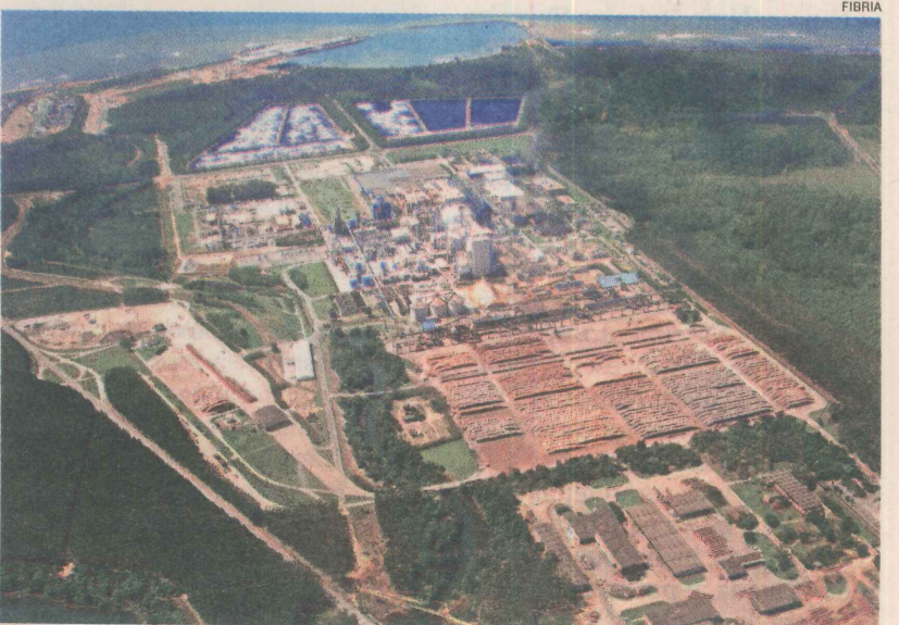
UNIDADE DA FIBRIA: modernização e ampliação de fábrica
