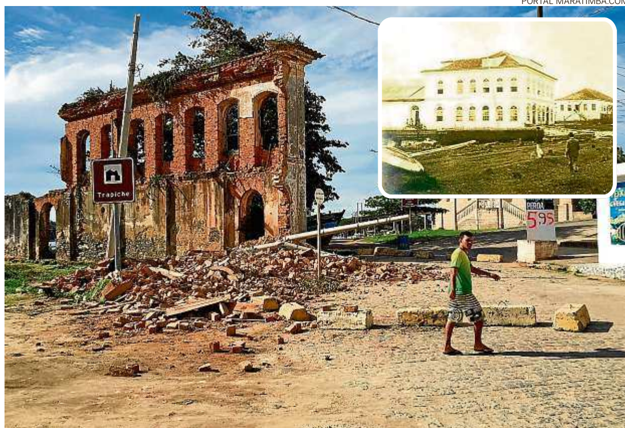
Fachada do monumento do Trapiche, onde restou apenas a parte frontal do imóvel, construído no século XIX
