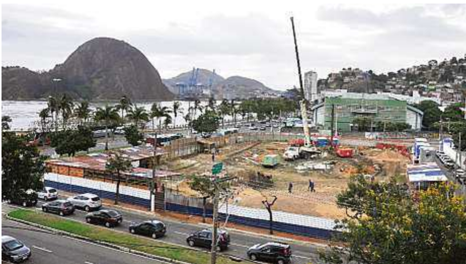
As obras do edifício da Receita Federal, em Vitória, sairão por R$ 46,134 milhões
