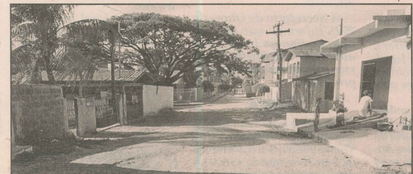
Na rua 4, a falta de pavimentação leva a buracos e poeira
