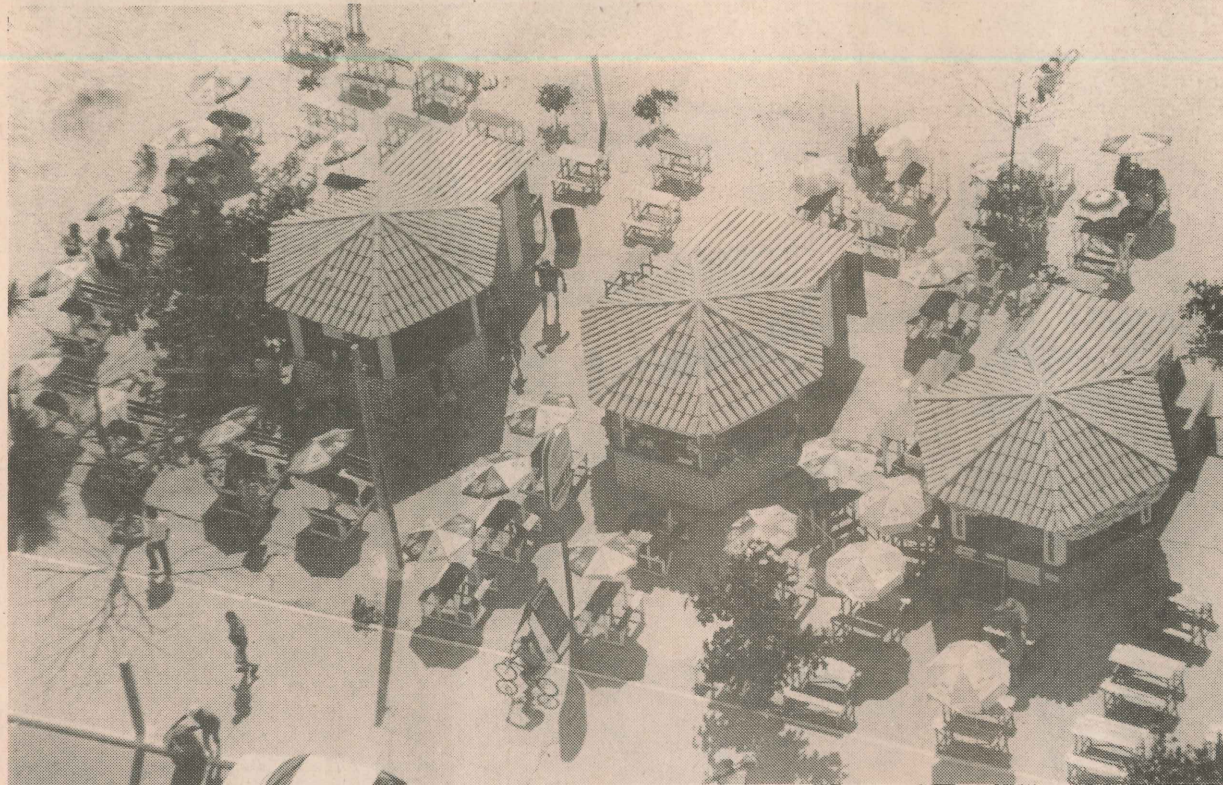
A construção de 153 quiosques em Itaparica, alguns com banheiro, pode provocar a contaminação da praia.
