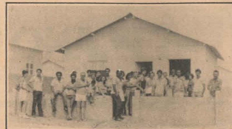
Na época da escolha das casas, os cooperativados visitam as obras em companhia dos diretores da Cooperativa, ficando, assim, orientados para fazer uma boa escolha
