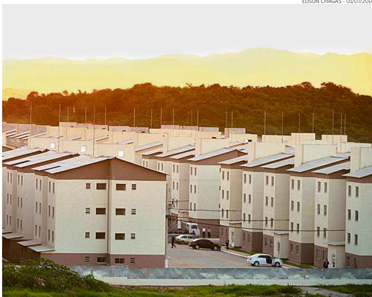
Empreendimento do Minha Casa em Jabaeté, Vila Velha, uma das maiores obras do programa no Estado
