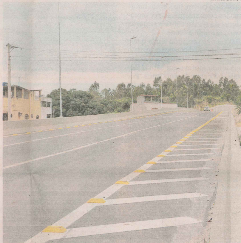
TRECHO do viaduto em Vila Velha, onde motoristas abusam da velocidade
