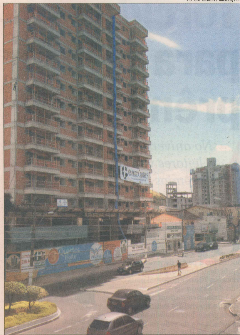
Um dos edifícios em construção no bairro Santa Lúcia, em Vitória
