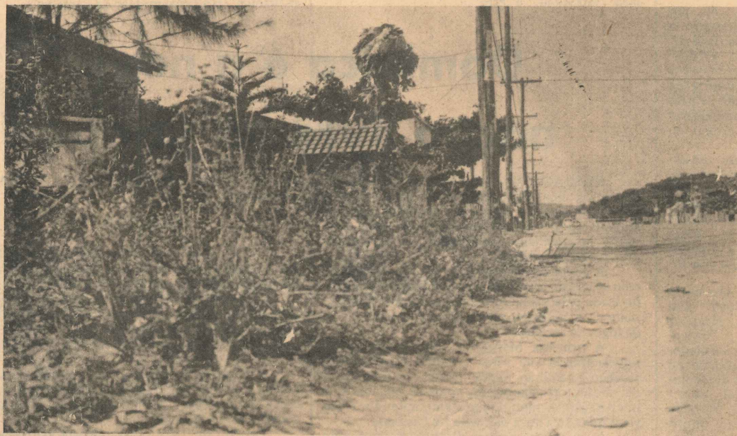
Falta até calçamento nesse bairro construído pelo Inocoop-ES
