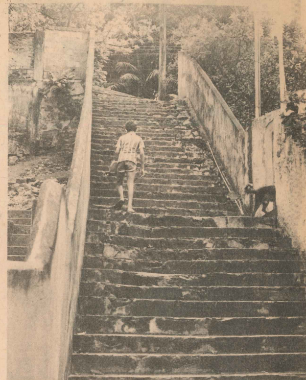
As escadarias são motivo de reclamações
