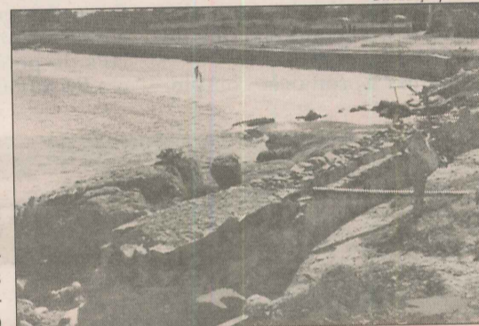
Construção de muro perto do Libanês
