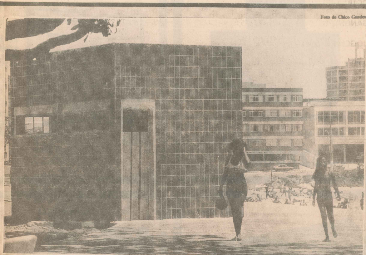
Depois de muita discussão, o banheiro será demolido para dar lugar aos módulos comerciais
