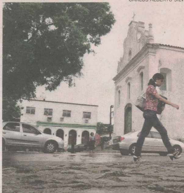
Asfalto deve ser retirado; e fachadas, reformadas
