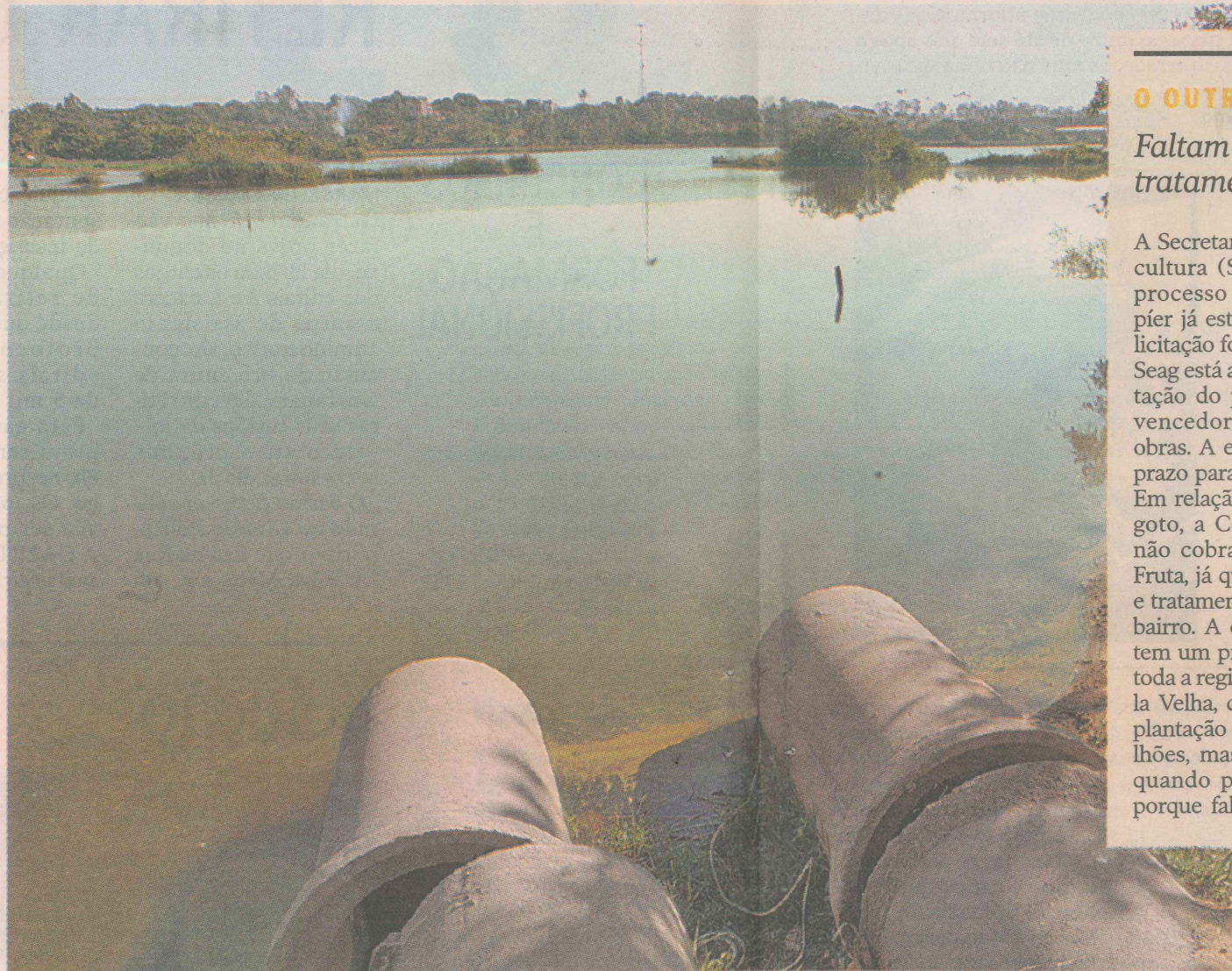
SUJEIRA. Esgoto residencial é despejado por manilhas na lagoa ou no mar. Em muito pontos, ele transborda no meio das ruas. FOTO: GABRIEL LORDÉLLO
