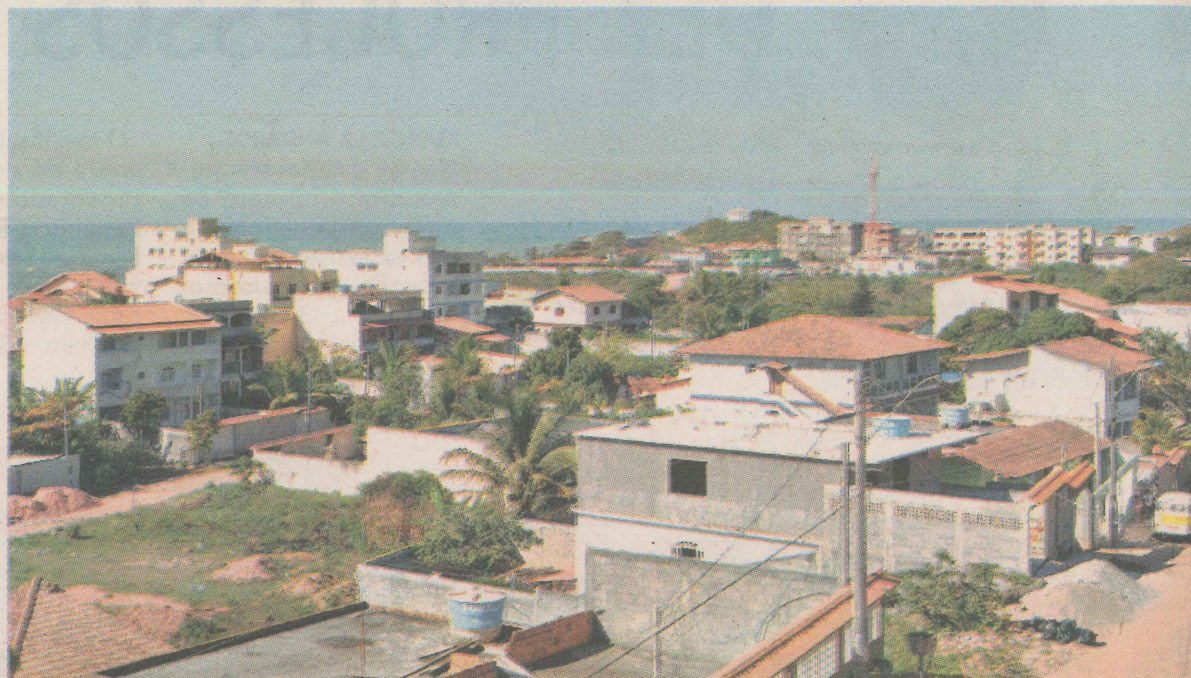
COMUNICAÇÃO. José Maria Rodrigues, o tio Zé (acima à direita), conta que o bairro começou a crescer entre as décadas de 1970 e 1980, quando foi instalada a rede de água e de telefonia. FOTOS: GABRIEL LORDÉLLO
