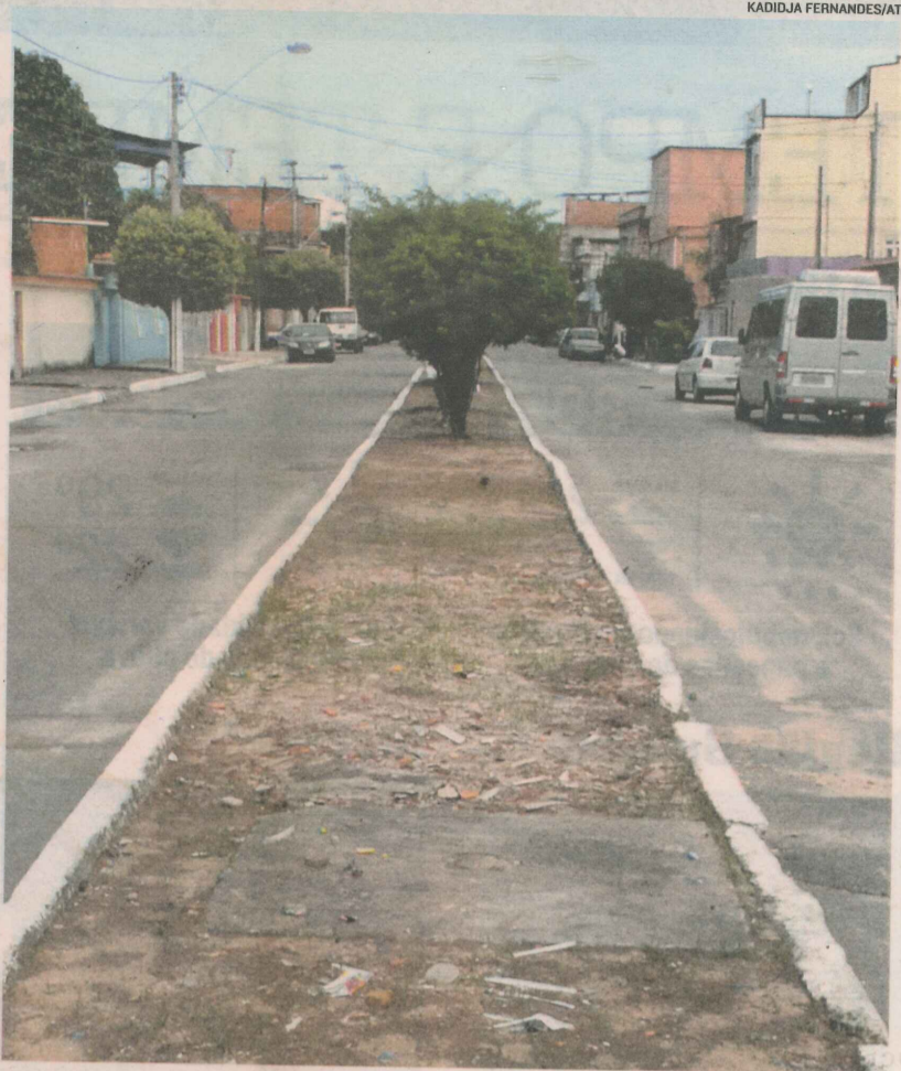
RUA RIO DE JANEIRO, onde houve expansão da iluminação e paisagismo
