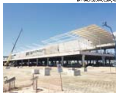
OBRAS avançam no aeroporto
