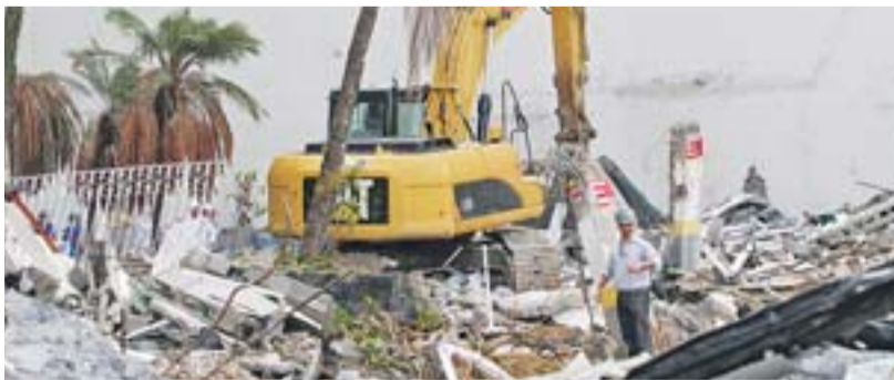
MÁQUINA é usada para retirar escombros: 160 famílias ficaram desalojadas
