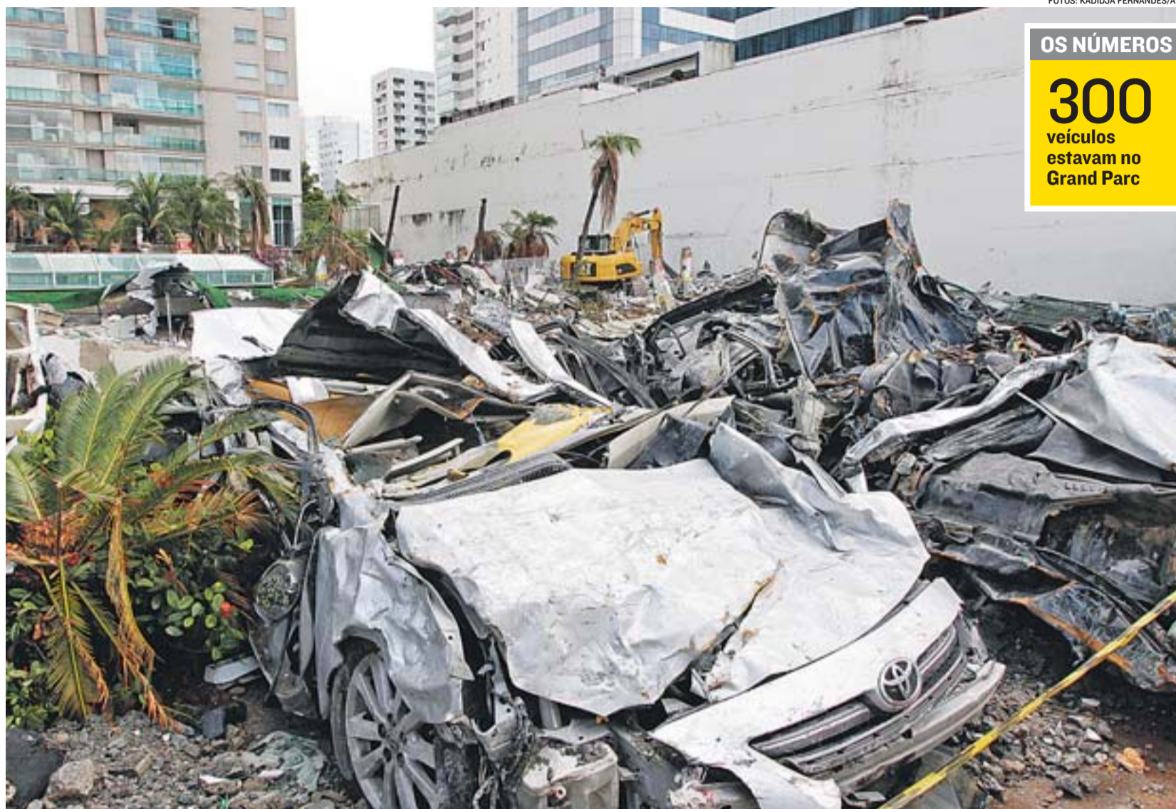
VEÍCULOS que estavam sob os escombros do condomínio Grand Parc, na Enseada do Suá, desde julho do ano passado, ficaram completamente destruídos
