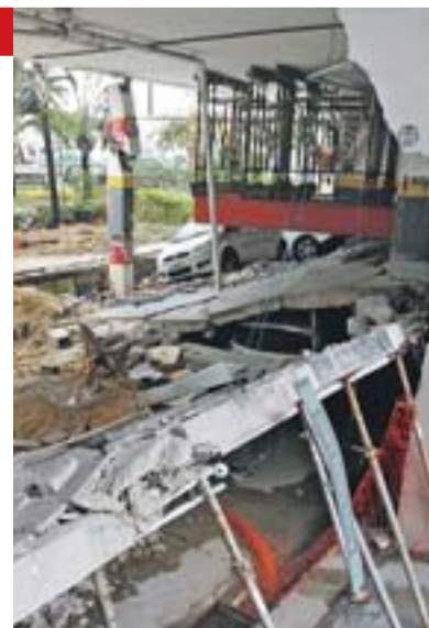
ÁREAS DE CIRCULAÇÃO do condomínio e garagem superior foram totalmente destruídas com o desmoronamento.
