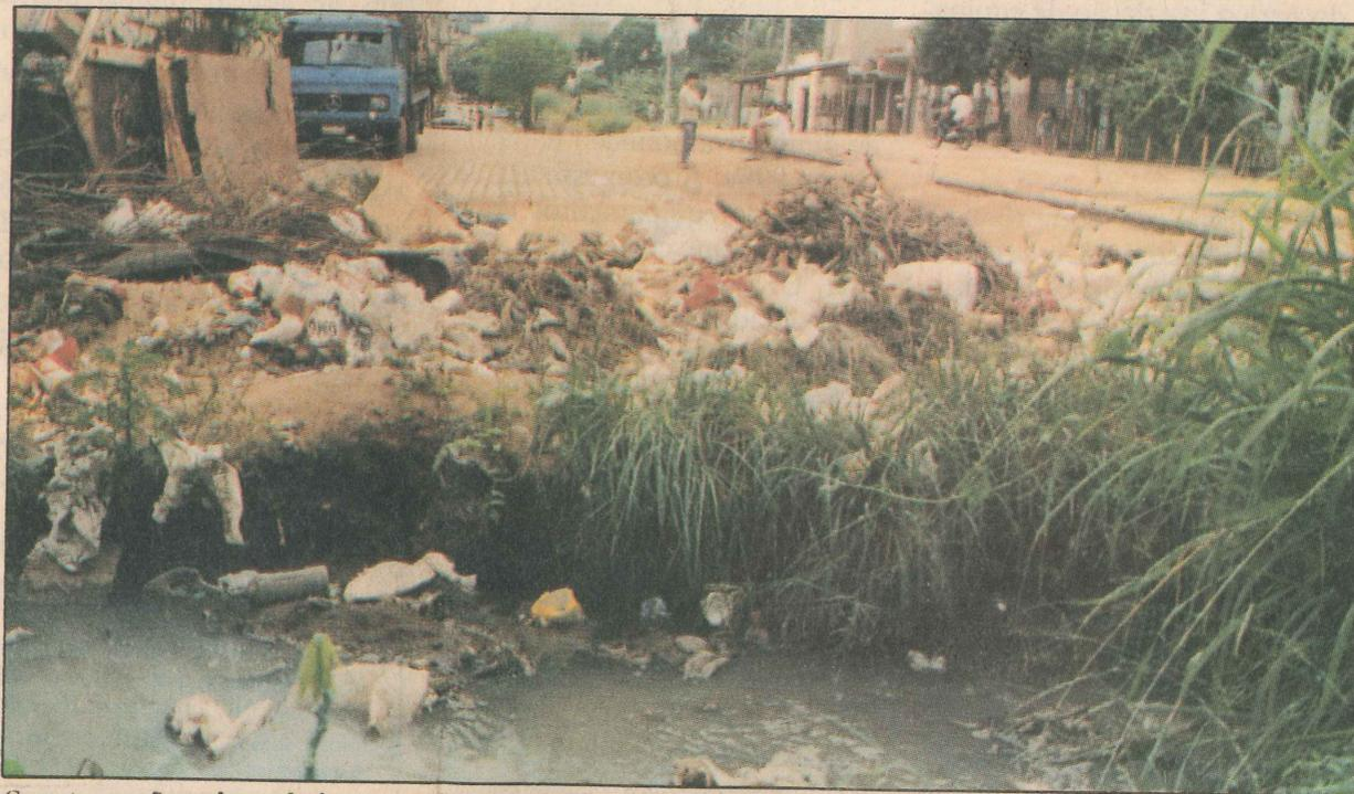
Sem ter vazão pelas galerias, entupidas com lixo e areia, o esgoto em várias ruas corre a céu aberto
