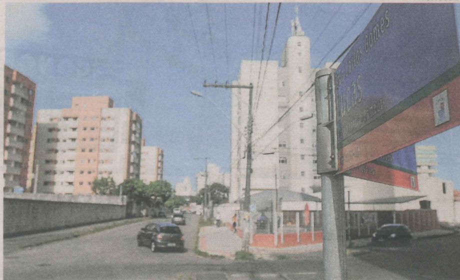
Rua Carlos Gomes Lucas é uma das que devem receber obras de drenagem
