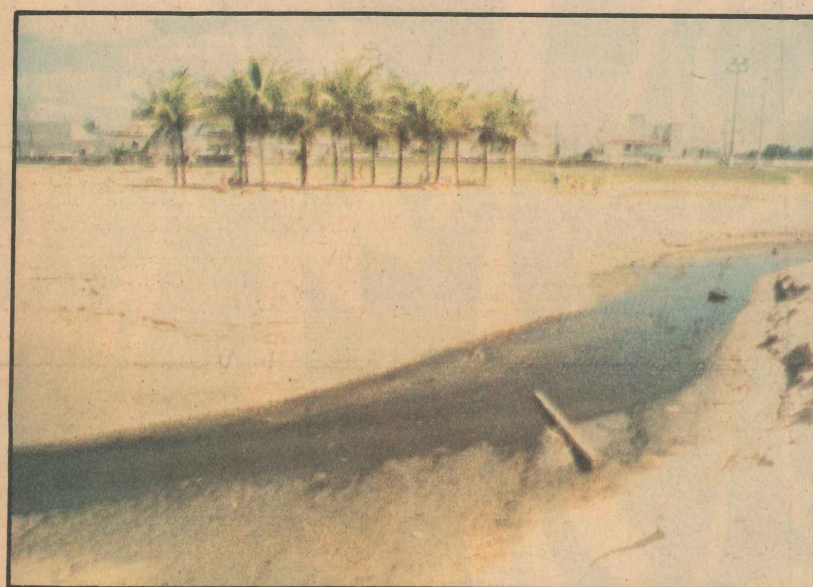
O esgoto do bairro, sem tratamento, é despejado na praia de Camburi
