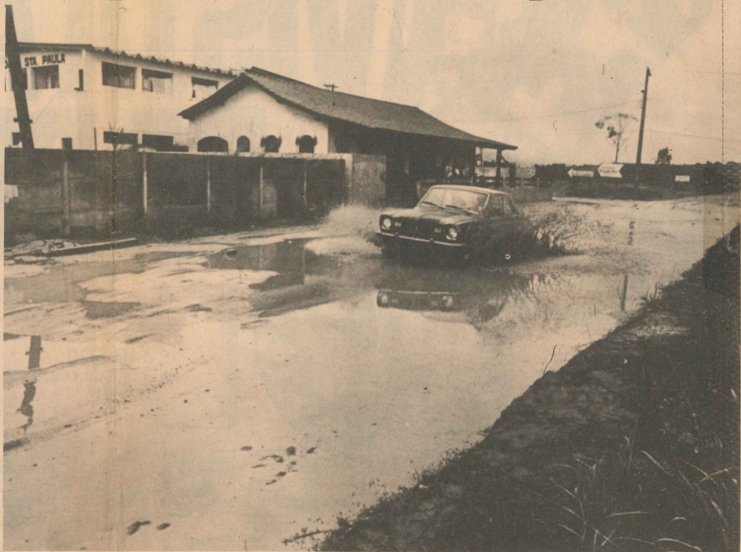
Esta rua retrata bem a situação de Jardim Camburi, um bairro classe média, mas carente dos serviços de infra-estrutura
