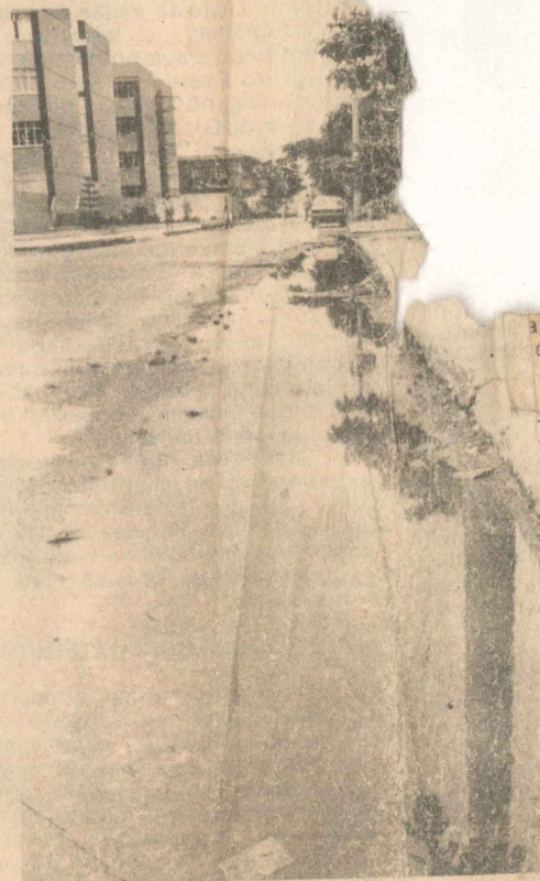
Não há escoamento para as águas nas ruas
