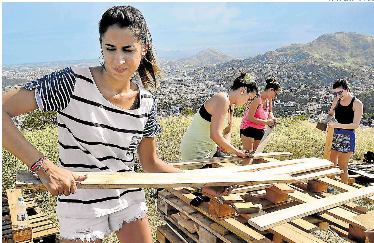
Moradores e voluntários estão colocando a mão na massa para construir o mirante, que será feito de paletes e terá vista privilegiada
