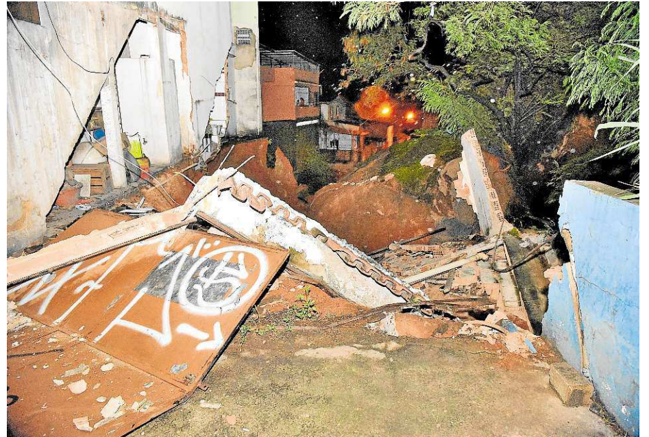
Garagem que ficava ao lado da linha foi destruída quando a rocha rolou
