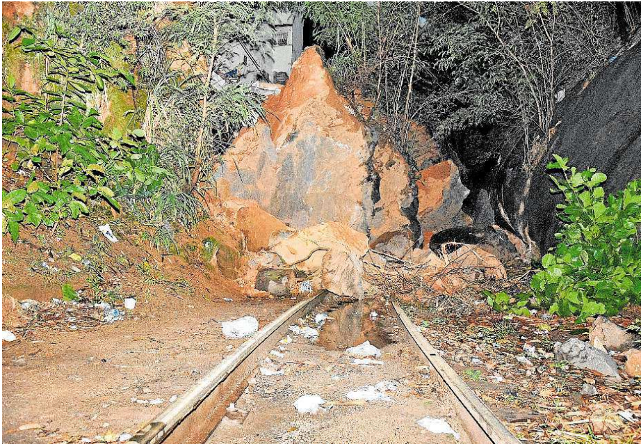
Pedra caiu sobre linha férrea, fechou a passagem e entortou os trilhos
