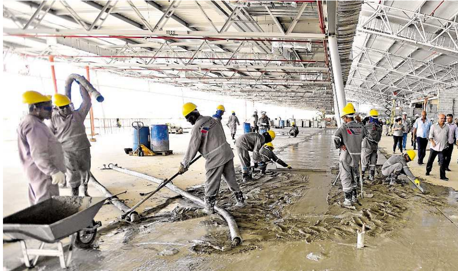
Profissionais trabalham na construção da pista de pouso e decolagem do Aeroporto de Vitória e na colocação de pisos do novo terminal de passageiros
