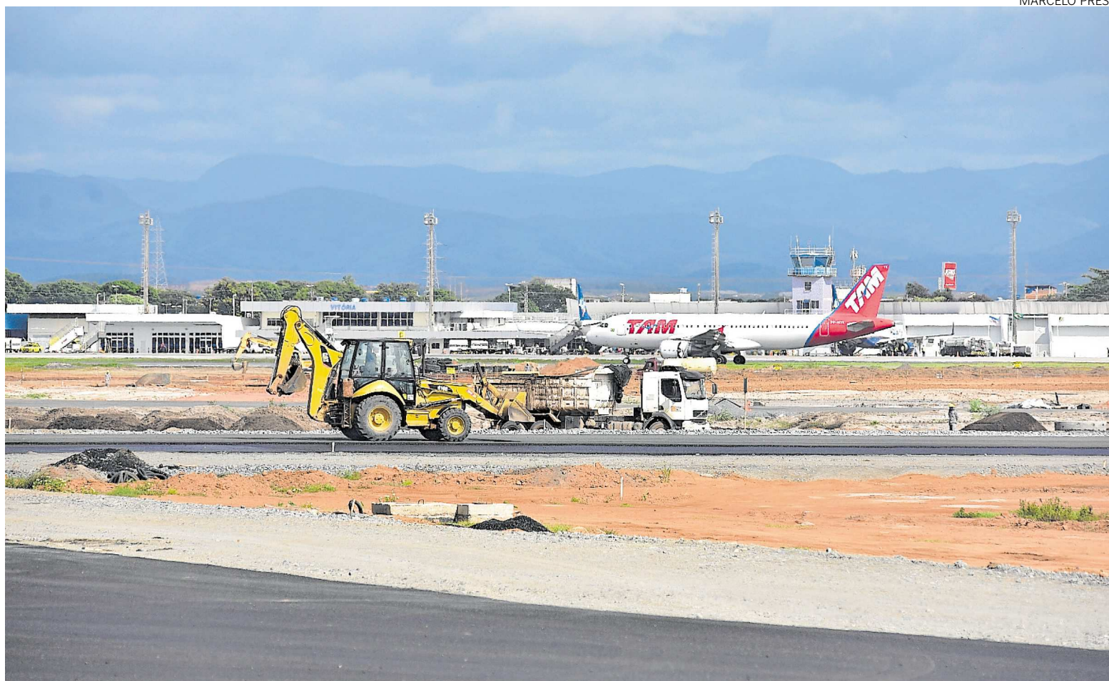
Obras de ampliação do Aeroporto de Vitória, prometidas há mais de 10 anos, estão atualmente com 65% dos trabalhos concluídos
