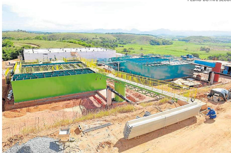
Estrutura do sistema de captação e tratamento já está quase pronta
