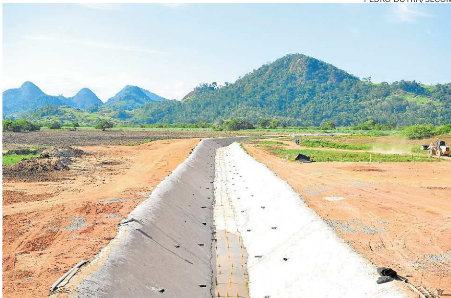
Tubulação vai levar água para um outro reservatório, na Serra-Sede
