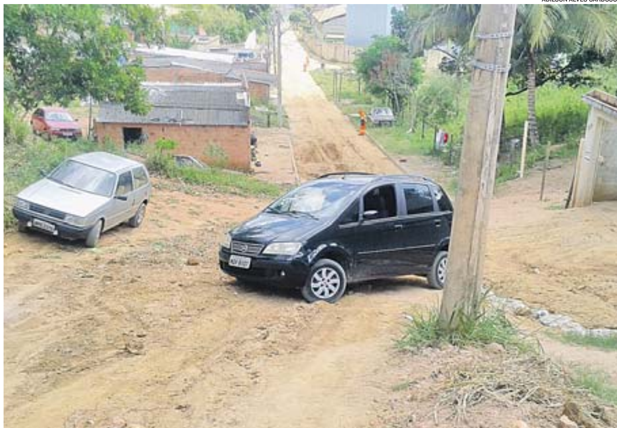
TRECHO da avenida Argentina, em Vista da Serra, não é asfaltado e problemas como poeira e barro incomodam
