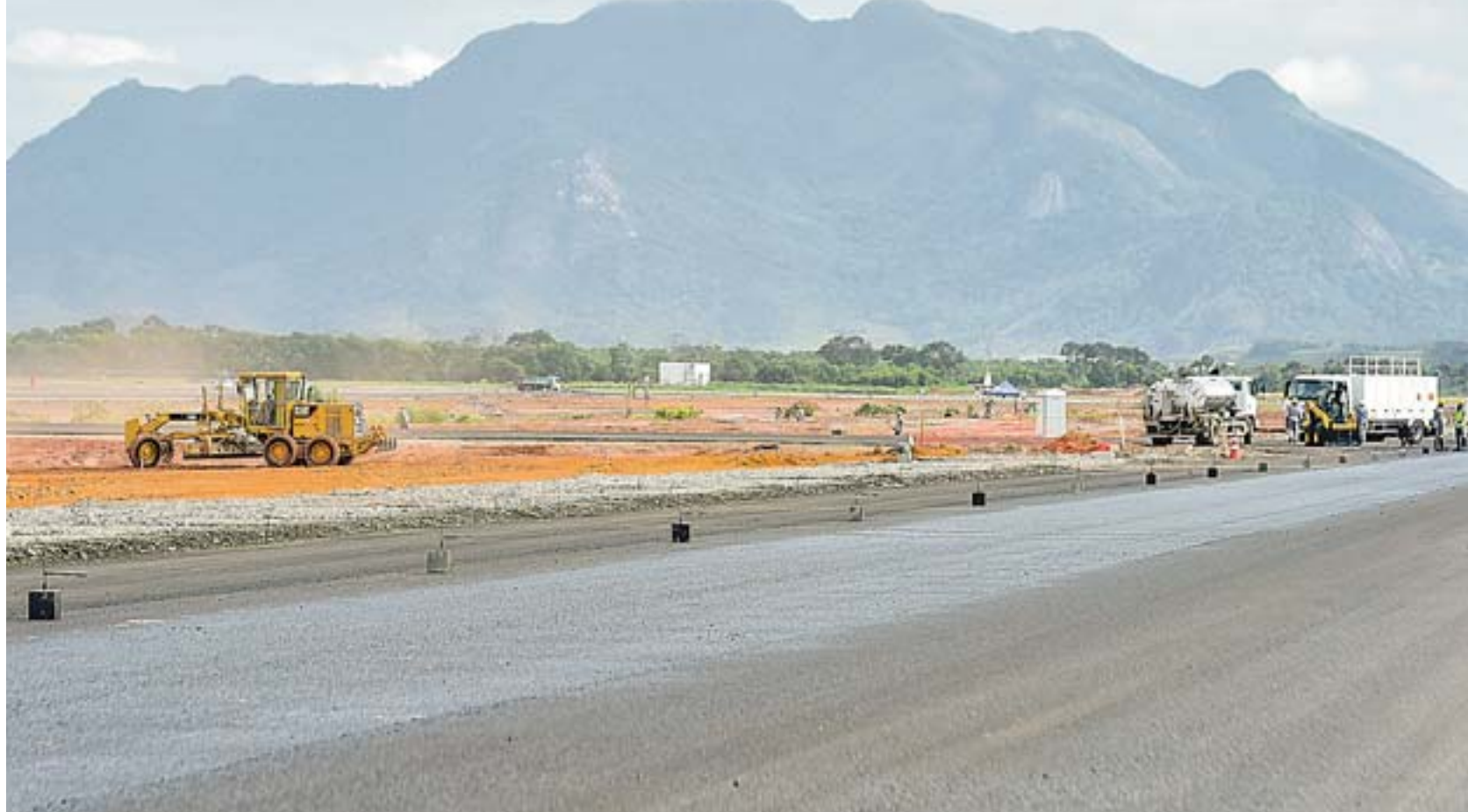
PISTA DO NOVO AEROPORTO VITÓRIA já recebeu três camadas de asfalto e outras três ainda serão feitas para aguentar o peso dos aviões
