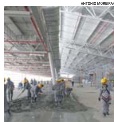
TRABALHADORES durante obra
