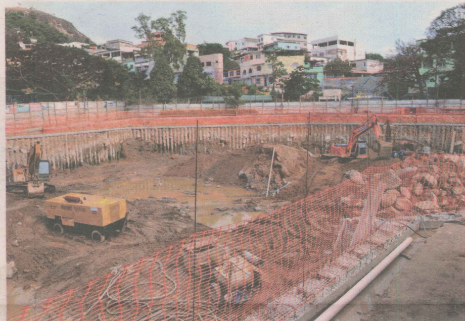
Obras no Horto de Maruípe geram barulho intenso, diz a moradora Maria de Fátima
