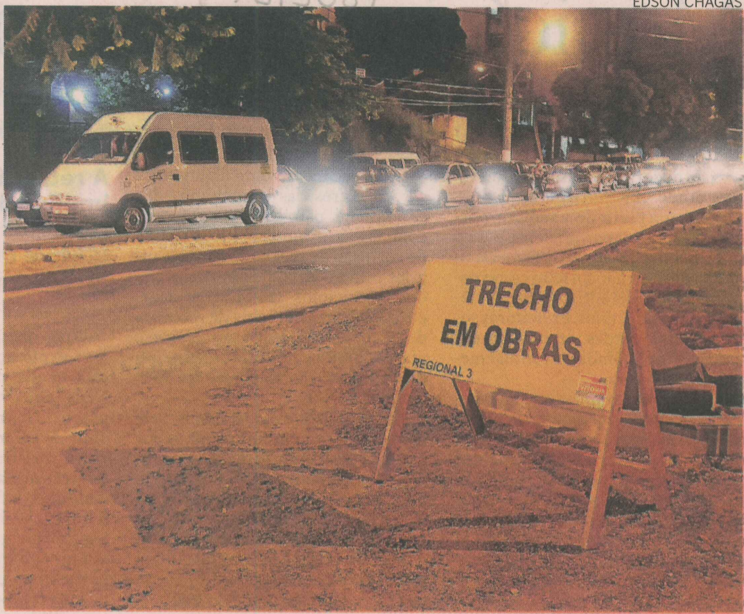
OBRA. Por conta das intervenções na Rua Henrique Rosetti, fluidez no trânsito ficou prejudicada
