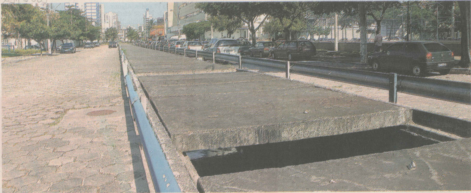
ESPAÇO. A Avenida César Hilal vai ganhar duas novas faixas de trânsito no trecho que corta o bairro, além de uma faixa de estacionamento em cada lado da via. FOTO: EDSON CHAGAS
