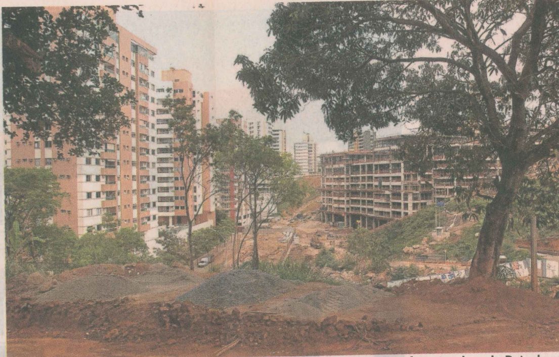
INVESTIMENTO. Parque, que seria construído pela prefeitura, agora será custeado pela Petrobras
