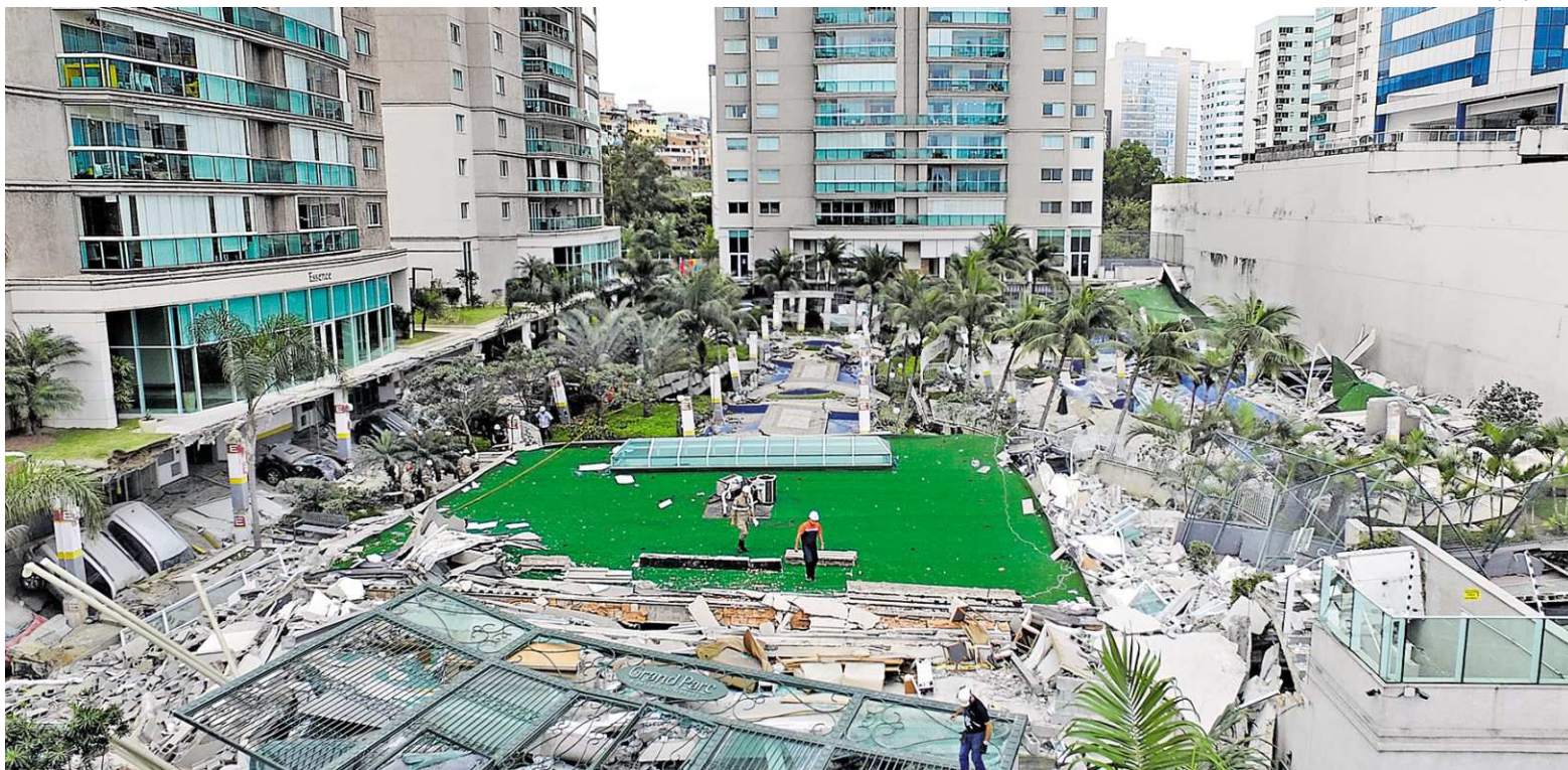
Área de lazer do empreendimento após o desabamento: caso deixou um morto e quatro feridos. Os apartamentos foram interditados
