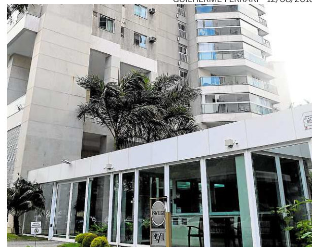
Apartamentos apresentaram vazamentos de gás
